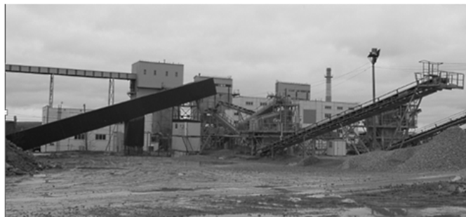
Рис. 1. Ленточный конвейер – основной источник внешнего шума на территории ОАО «Гурово-бетон»
