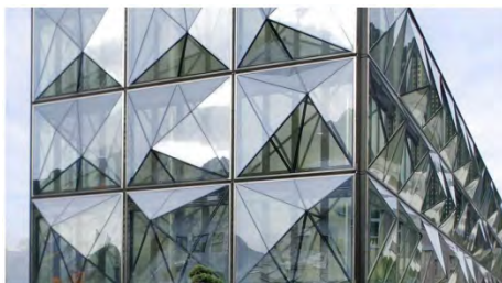
Рис. 1 – Фасады навесных стен
