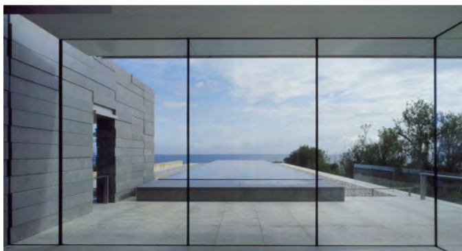
Рис. 4 – Безрамные остекленные фасады.
