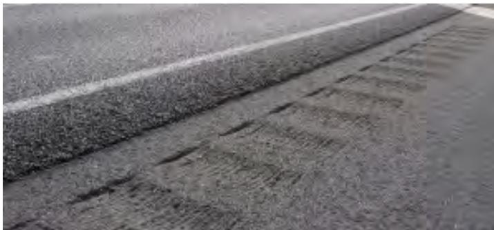
*Рисунок 1 – Фрезерованная виброполоса*
